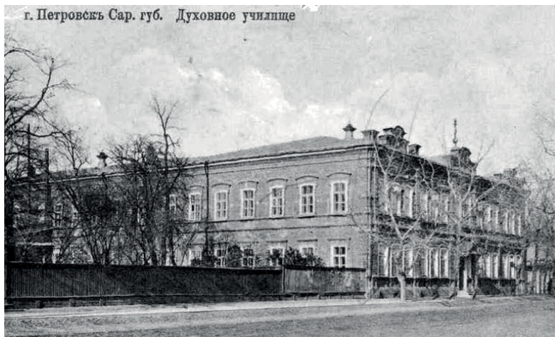
Город Петровск. Двухэтажный каменный дом духовного училища 1879 года постройки. После 1917 года в нем размещались школа, затем Петровский педагогический техникум и педагогическое училище
